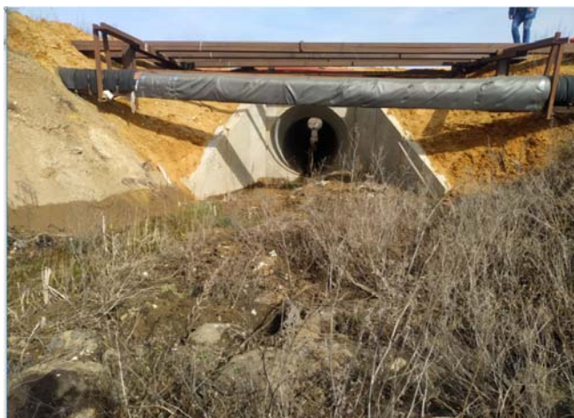
Рисунок 7.7 - Участок 1. Водопропускная труба. Вход в трубу в районе скв. 19.
