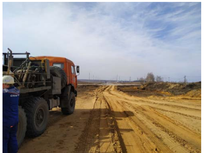
Рисунок 7.6 – Участок 1. Вид на запад со скв. 16 в сторону (скв.17) существующей автодороги (примыкание)
