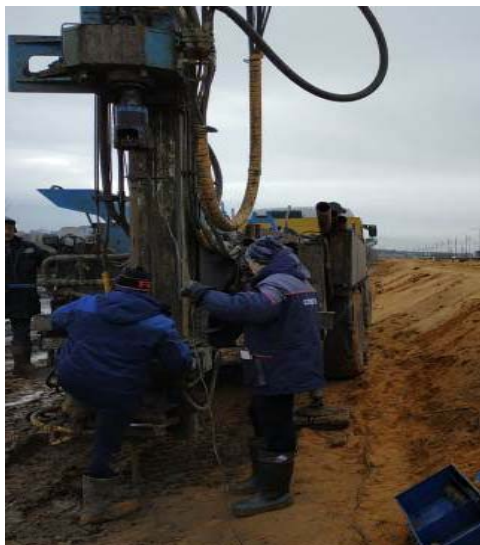
Рисунок 4 - Проведение испытания грунтов статическим зондированием
