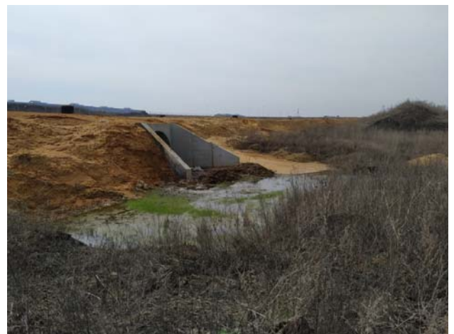
Рисунок 7.8 - Участок 1. Водопропускная труба. Выход из трубы в районе скв. 20
