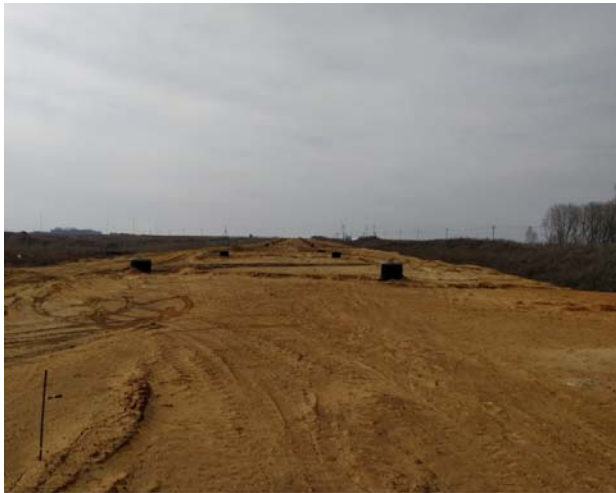
Рисунок 7.3 - Участок 1. Вид со скв. 13 на запад в сторону перехода через ручей
